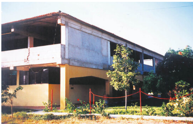
► Construcción del Edificio Administrativo Roque Morelli Zárate. Año 1996.
