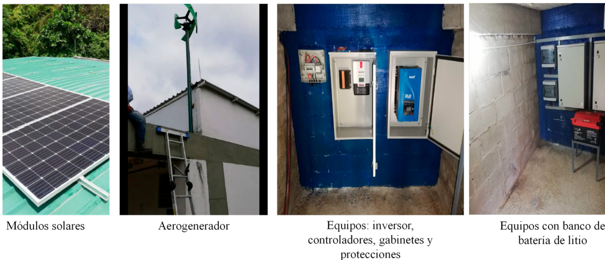
Figura 21. Sistema híbrido implementado en la IED La Revuelta, sede San Rafael
