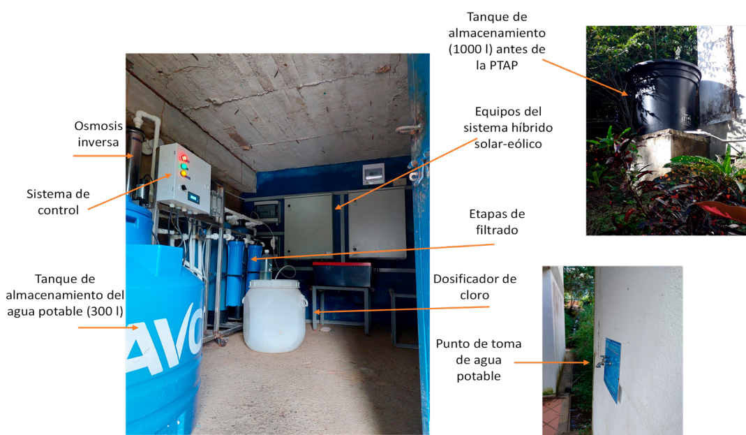
Figura 23. PTAP implementada en la IED La Revuelta, sede San Rafael (420 l/hora)
